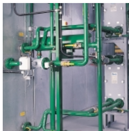
Фитинги под пайку для рационального монтажа в промышленных теплогенерационных, вентиляционных и холодильных установках.
