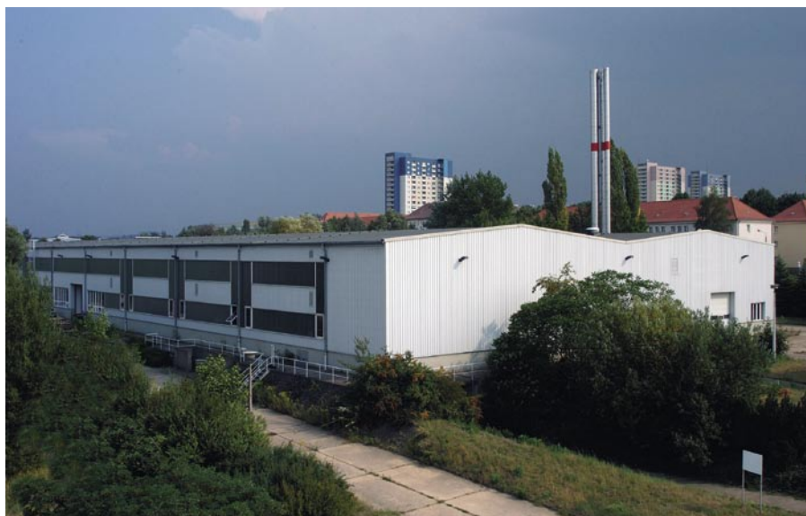
Фото сверху: Завод в г. Аннемасс, Франция. Слева: Завод в г. Пирна, Германия.
